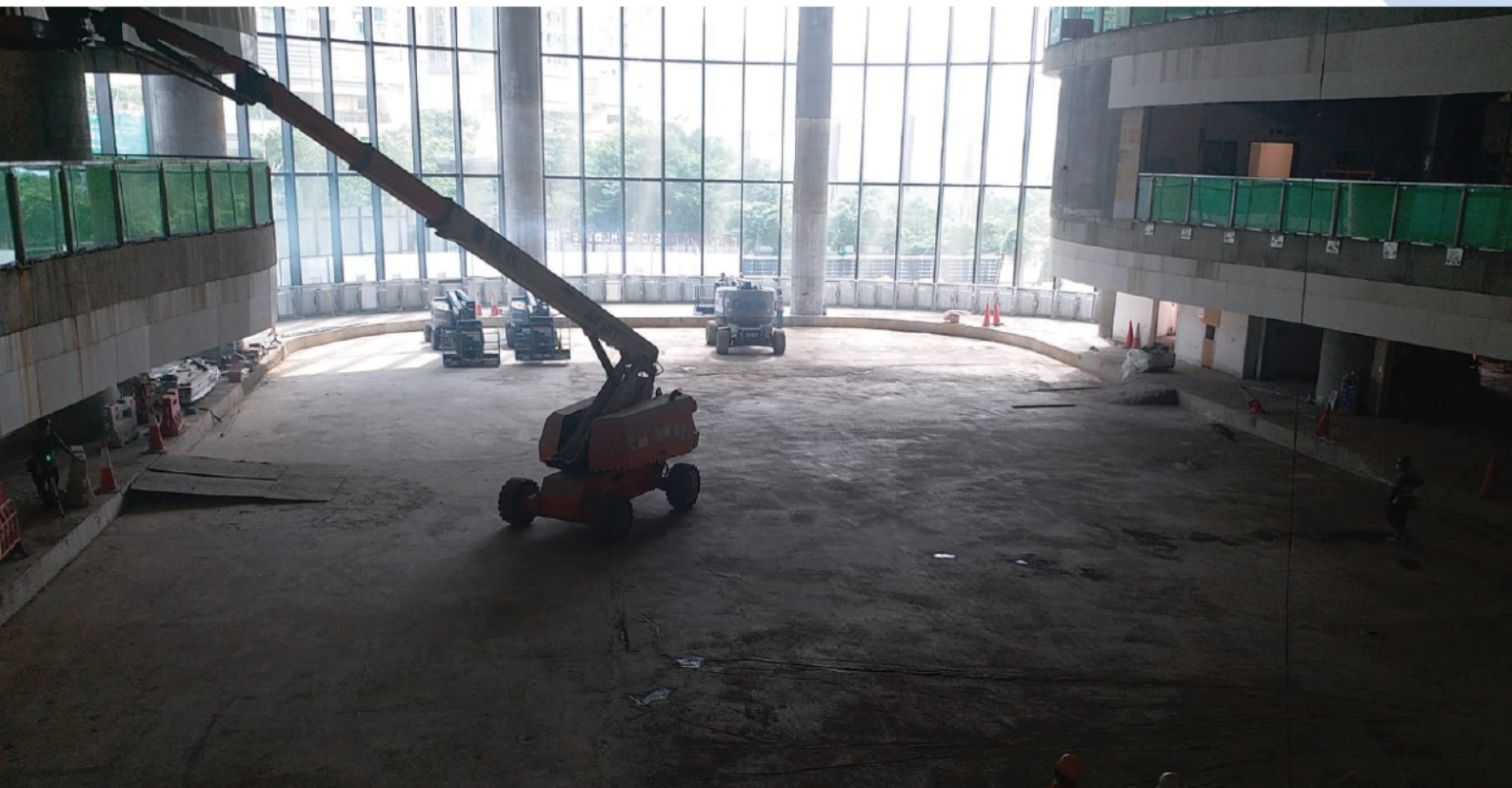
日出康城溜冰場施工情況
