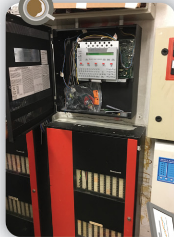
新的分層控制器（上） 會先安裝， 測試後才將舊有的拆除
